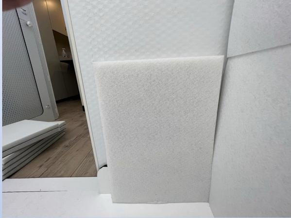
2 段目以降は左壁同様に貼り付け完成させます
